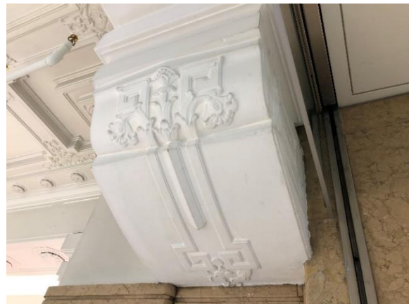
日本橋高島屋 S.C.本館入口の吹き抜けに面する 柱頭の肘木風モチーフ
