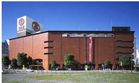
【高崎】 9月全館改装 駅と高架橋で接続
