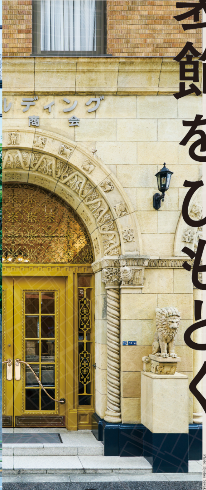
丸石ビルディング 設計 山下野郎建築事務所(現山下設計), 1931年竣工
