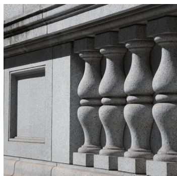
5. 旧建築の手摺子(スターツ日本橋ビル)
