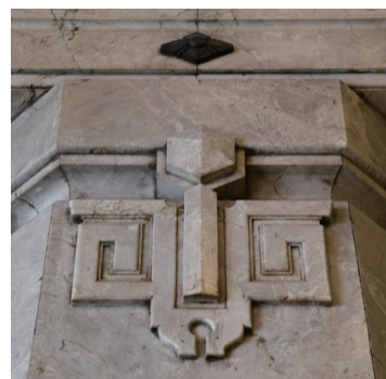
2. 正面入口の柱頭(日本橋高島屋本館)
