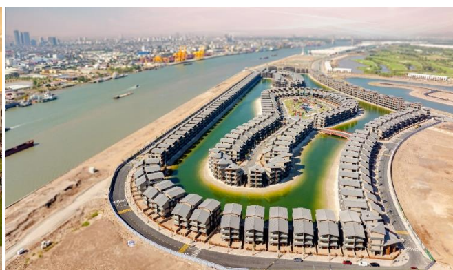
【既参画街区内の中央街区 竣工写真】
