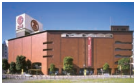
高崎 9月全館改装 駅と高架橋で接続
