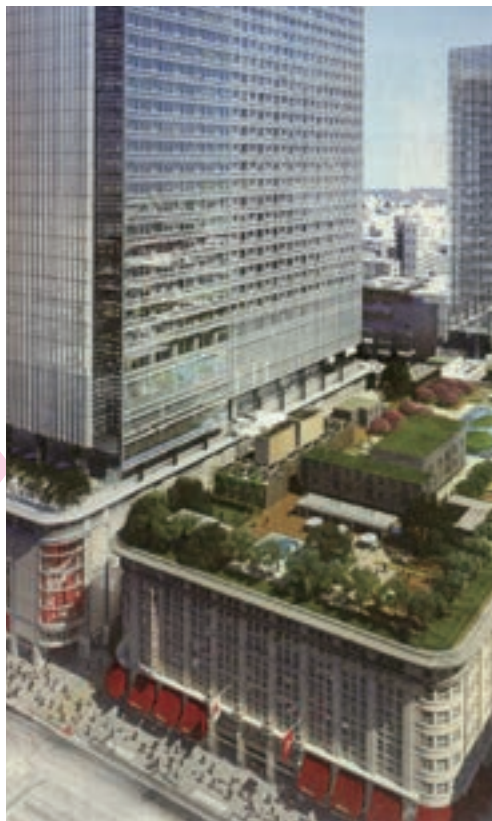
日本橋再開発 2018年秋 新館開業 2019年春 本館改装
