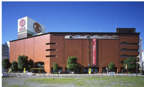
【高崎】 9月全館改装 駅と高架橋で接続
