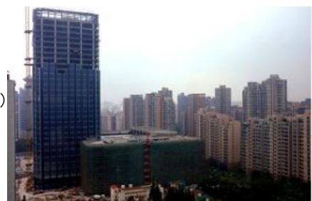
建設が進む上海高島屋(2011年9月現在) 左建物はオフィス棟 後方建物は高級タワーマンション群
