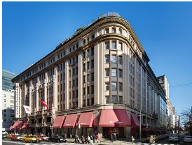
1933年建築部分(旧日本生命館)設計:高橋貞太郎
